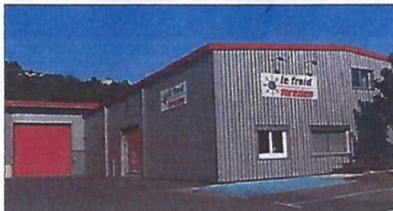
Le Froid forézien est situé dans la zone industrielle de la Bargette, 16, rue Léo-Lagrange. Photo FROID FORÉZIEN
